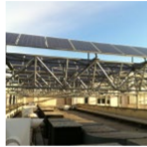
Figura 9. Impianto fotovoltaico del Dipartimento di Fisica (Sesto Fiorentino)
