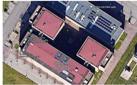
Figura 11. Impianto fotovoltaico sull'edificio Incubatore (Sesto Fiorentino)
